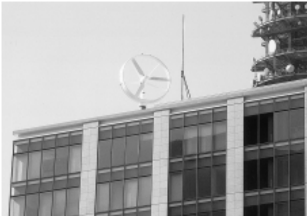
横浜のビル屋上の風車
