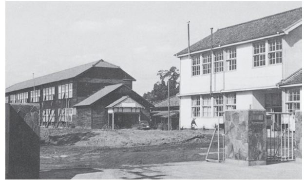
写真4 研究棟は支柱で補強。右側は事務棟
