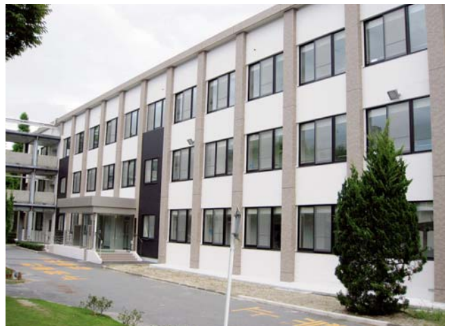
H26年4月に改修工事を終えた経済学部棟1号館
