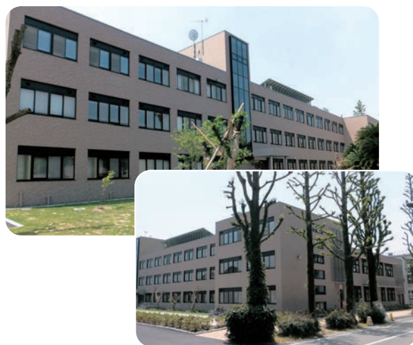
▲佐賀大学文化教育学部1号館改修完成 (平成26年3月31日竣工)▲
