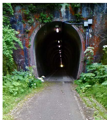
同自転車道トンネル
